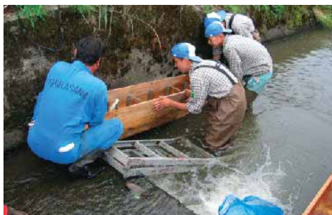
落差工への小規模魚道設置作業(改良版ノルウェー型魚道)
