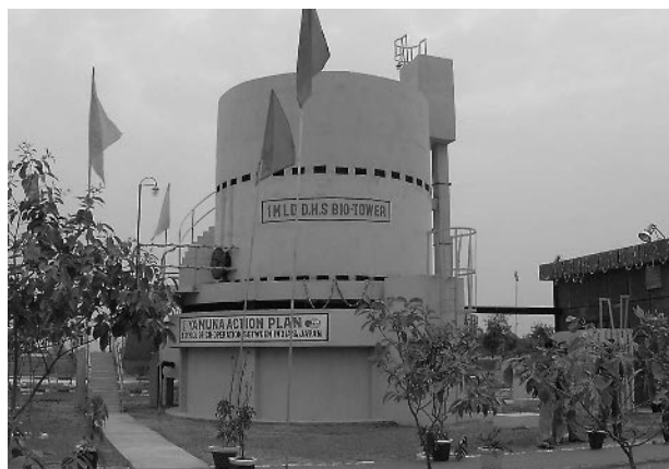
写真1 インド、カルナール市の下水処理場に設置されたDHSリアクター実証プラント（処理水日量1000トン、処理人口7000人規模）
