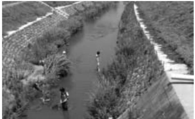
粗朶沈床工法で改修された箇所
