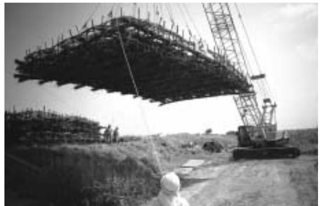
写真3 粗朶沈床を吊り上げてる状況
