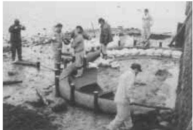
写真6 市民参加による造成工事
