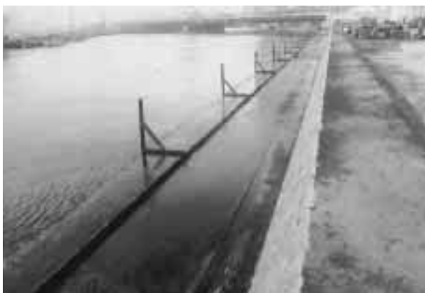
写真2 施工前の低水護岸の様子
