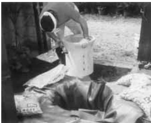
写真5 浸透ます設置中の現場
