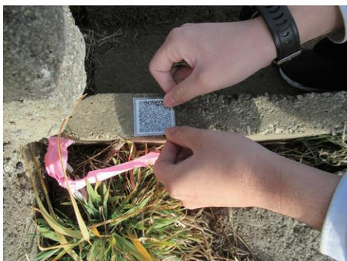
写真10 補修情報をQRコードにして貼り付け
