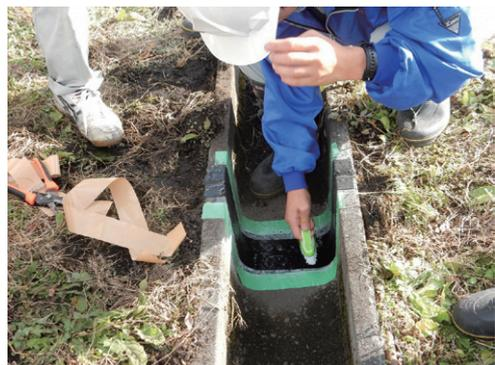
写真8 被覆テープによる被覆工法での補修
