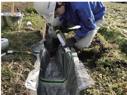
写真9 シーリング材による充填工法での補修
