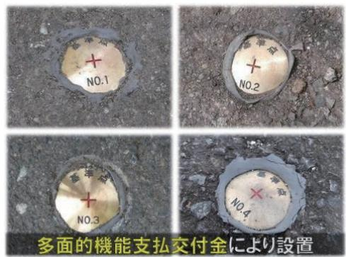
写真4 設置していただいた基準点
