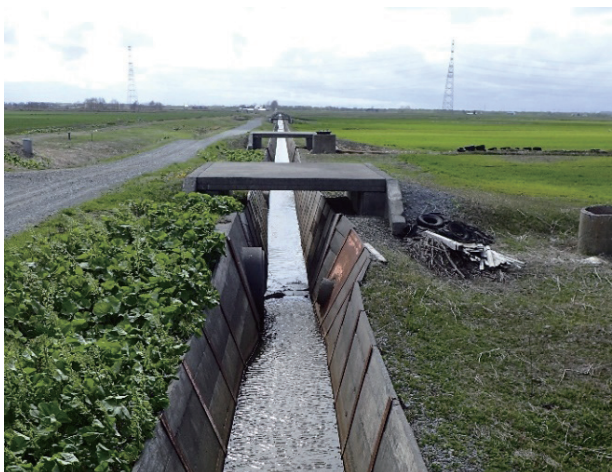
農地の沈下により放置状態にある耕作橋
