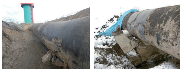
沈下の影響を受け機能低下した管水路
