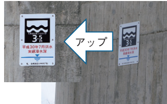
写真 平成30年西日本豪雨後の痕跡調査の様子
