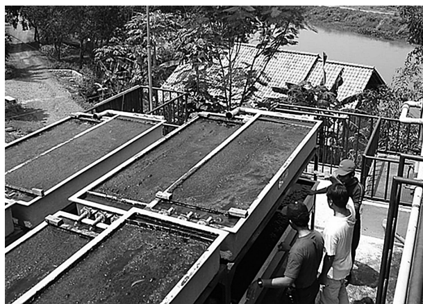
図7 浅い水路に藻を繁殖させ微小動物を増やす
