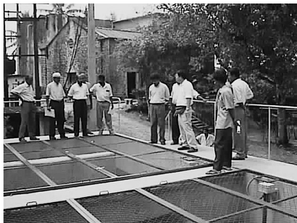
図16 完成時に生物浄化の仕組みを解説
