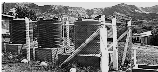
図33 雨水タンク利用の村の生物浄化装置
