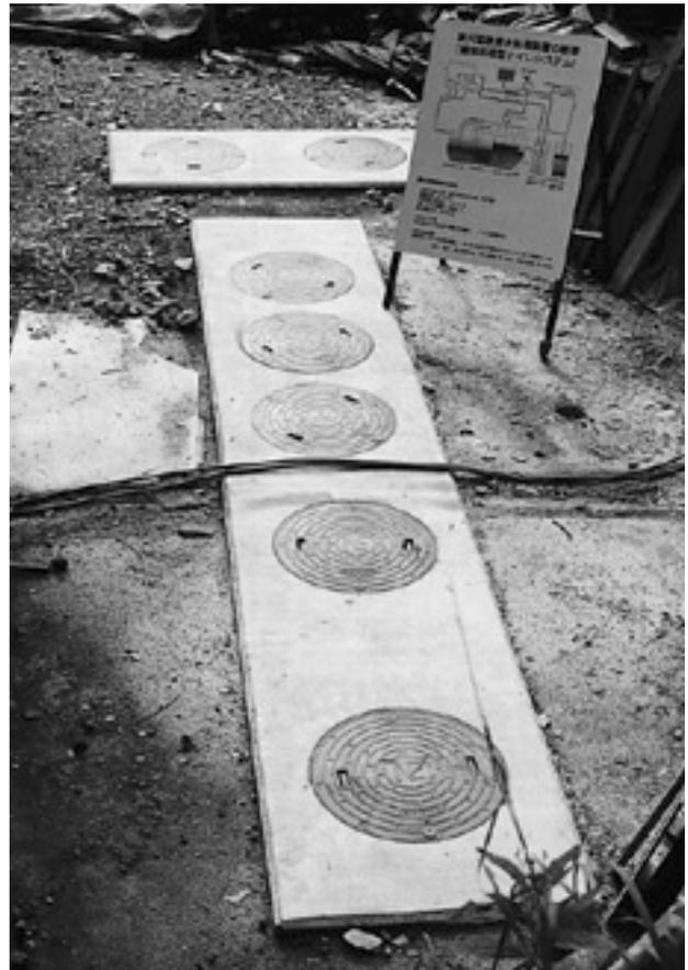
写真6 夏沢鉱泉の合併処理浄化槽を上部より見たところ。奥の右側のフタの下に「汚泥減量装置」あり
