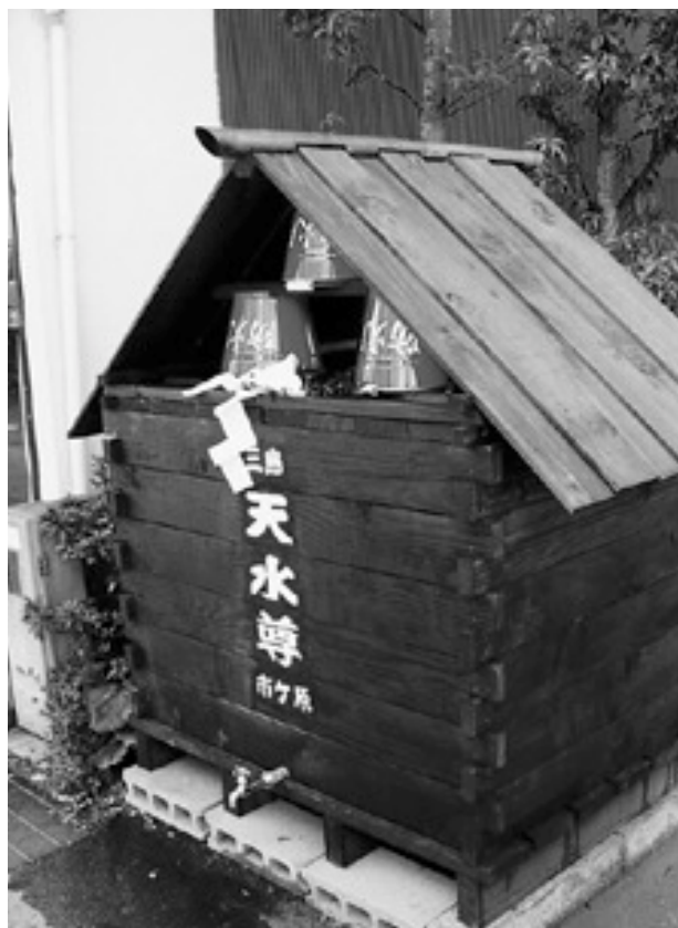
写真2 雨水貯留タンク「天水尊」
