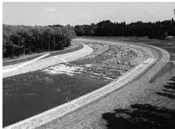
安全な河川に改修
