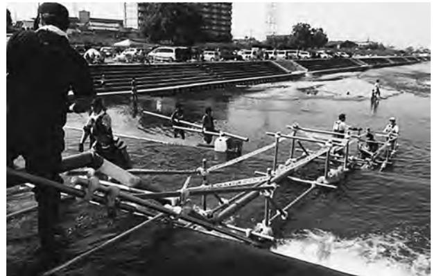
図7 地域と協働したパイプ式魚道の設置
