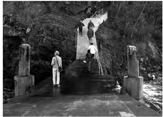
南三陸町荒島神社の登り口、鳥居・足場が津波に流され修復後に調査 (2014年)
