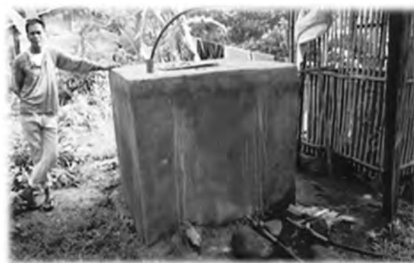
村の高台に設置した約2m 3 のタンク
