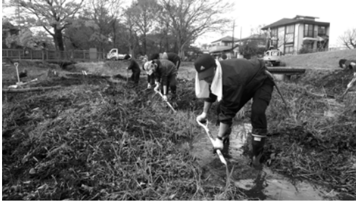
ワンデイチャレンジでの土羽水路づくり
