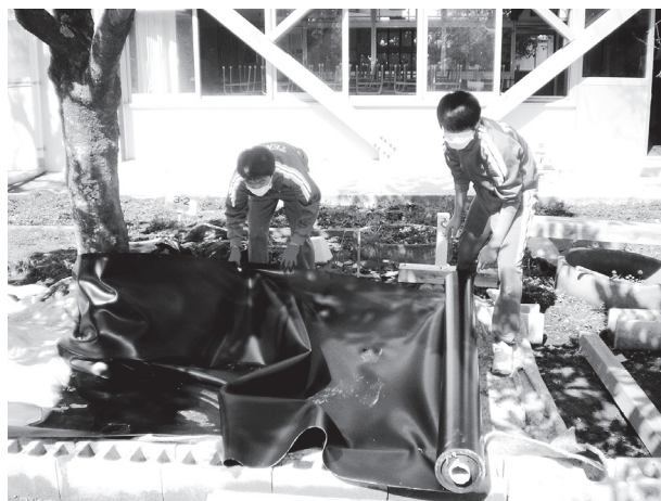
ホタルの池作り 防水シート張り 平成26年2月
