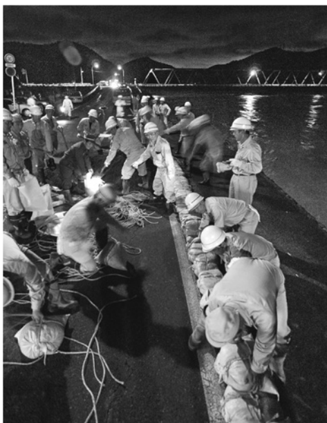
台風23号 堤防に土のうを積む水防団員 藍川橋上流 平成16年10月
