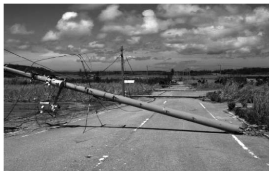
写真-1 台風14号の壊滅的な被害状況
