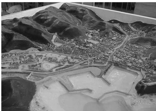
同地区は明治三陸津波と昭和三陸津波の40年足らずの間にそれぞれ1600名と972名の方々が死者行方不明となり、甚大な被害が出たところとして名高いところです。その後、国、県、田老村(当時)が防波堤の建設に着手、24年の歳月を経て海拔10m全長1,350mの防波堤が昭和33年に完成し、今では2,433mの長さに延長されています。世界でも類のない大防潮堤として外国人が見学に訪れています。模型は田老地区の小学校と中学校に寄贈し、宮古市田老総合事務所に設置され、地域の住民に避難場所の確認のため役立っています。
