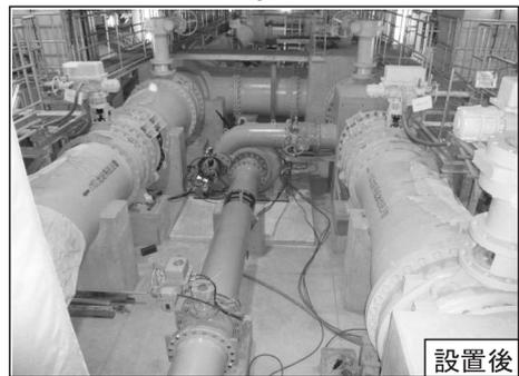
図5 水道施設でのマイクロ水力発電設置例
