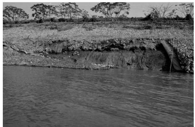
図2 蛇籠による侵食対策事例
