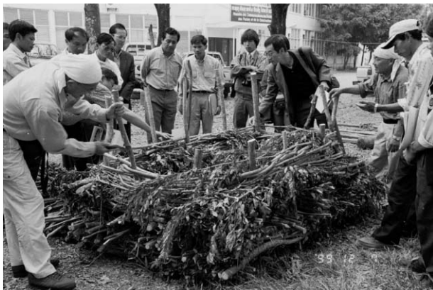
図3 粗朶沈床のデモンストレーション
