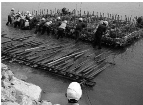
図8 水上で製作した粗朶沈床の設置 (ラオス事業：2008)
