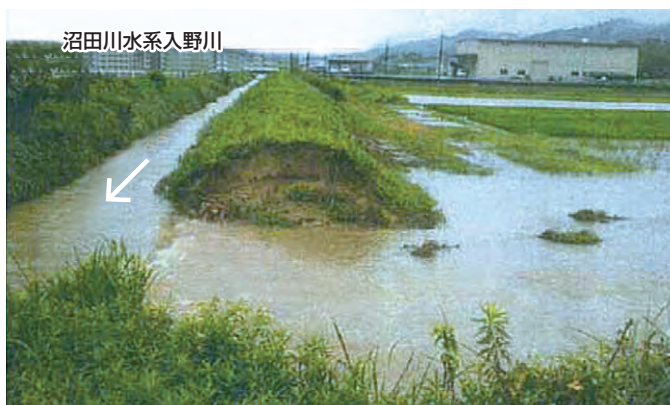
入野川の堤防決壊状況 広島県東広島市(国土交通省中国地方整備局HP)
