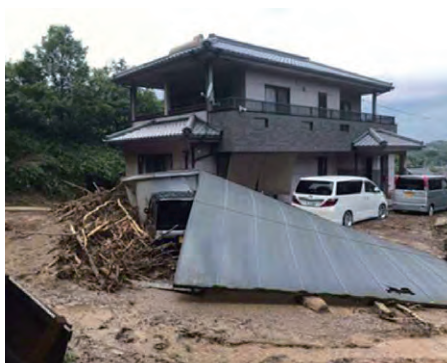
7/8 土石流等の状況 広島県三原市小泉町（国土交通省HP）
