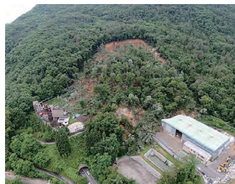
7/6 地すべりの状況 長野県長野市篠ノ井（国土交通省HP）
