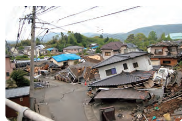
一階部分が倒壊した家屋(九州地方整備局HP)
