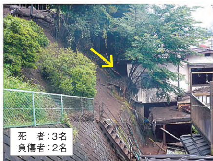
8/15 土石流の状況 長野県岡谷市市川岸東 (国土交通省HP)
