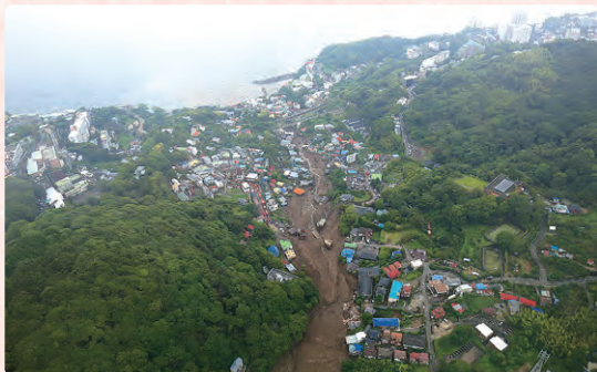
7月1日からの大雨による土砂災害 静岡県熱海市（国土交通省国土理院HP）
