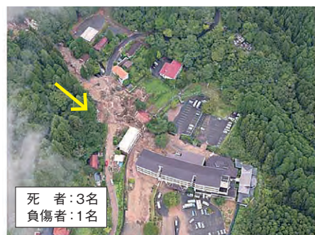
8/13 土石流等の状況 長崎県雲仙市小浜町 (国土交通省HP)
