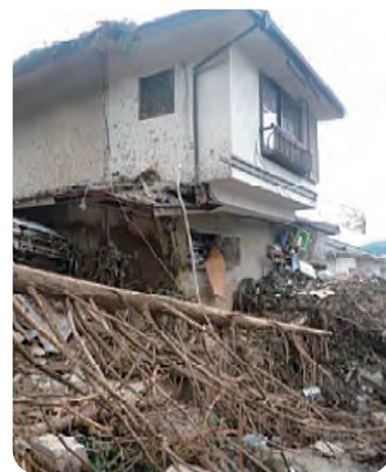
広島市の土砂災害による住宅被害状況（国土技術政策総合研究所HP）
