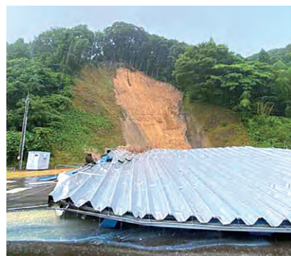
7/8 がけ崩れの状況 鳥取県倉吉市大原（国土交通省HP）
