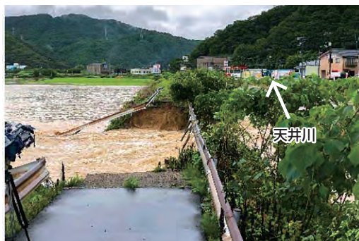
天井川の堤防決壊状況 広島県三原市(国土交通省中国地方整備局HP)
