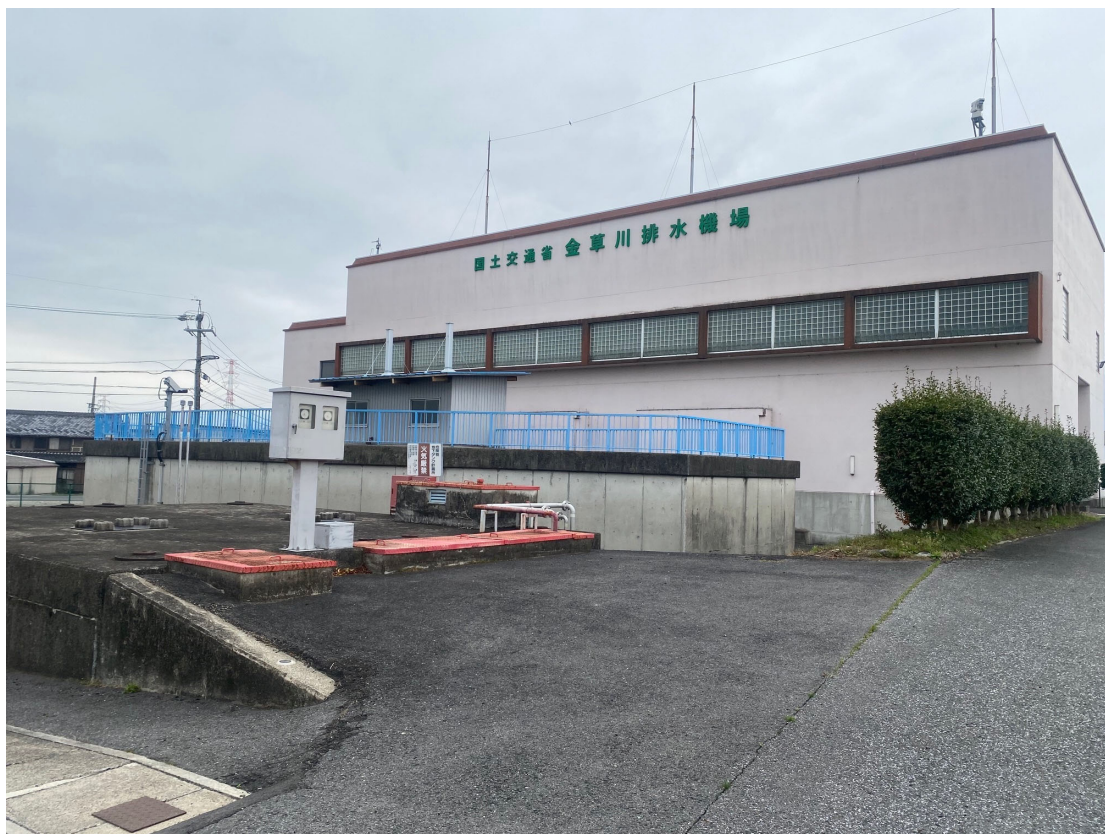
金草川排水機場
