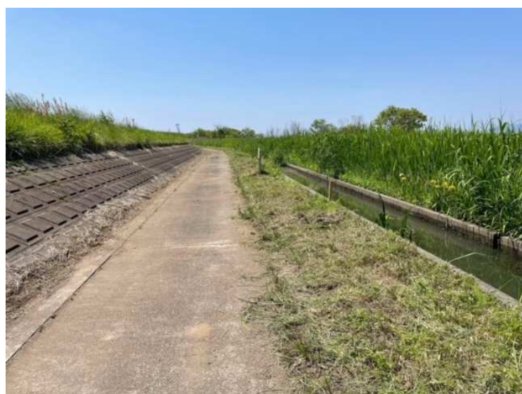
「草刈りを終えた導水路の手前側」
