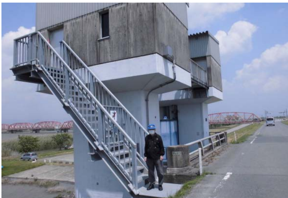
宇田貫排水樋管
