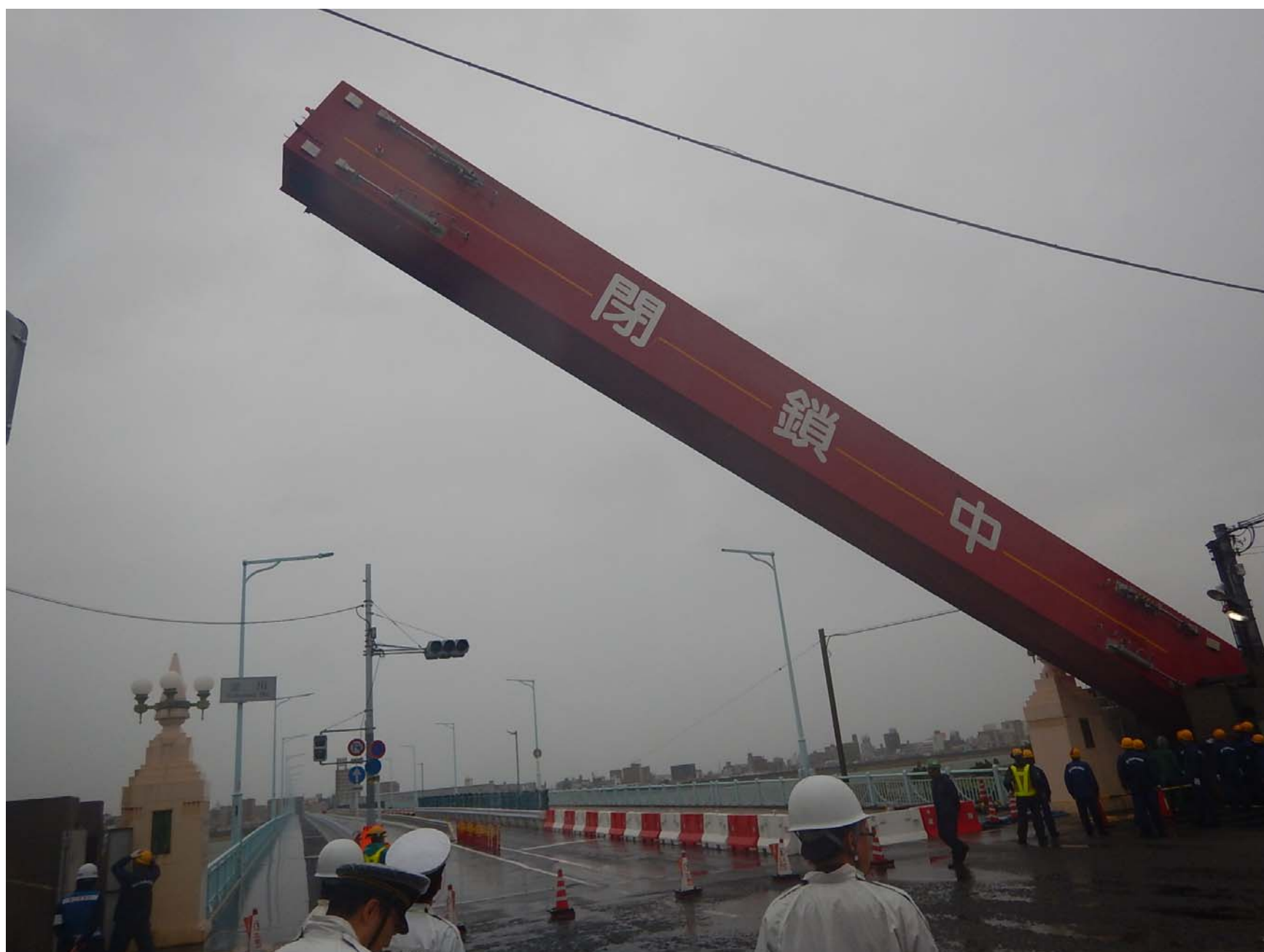
陸閘の閉鎖状況
