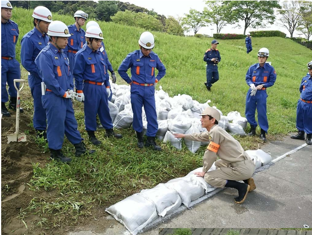
積土のう工指導
