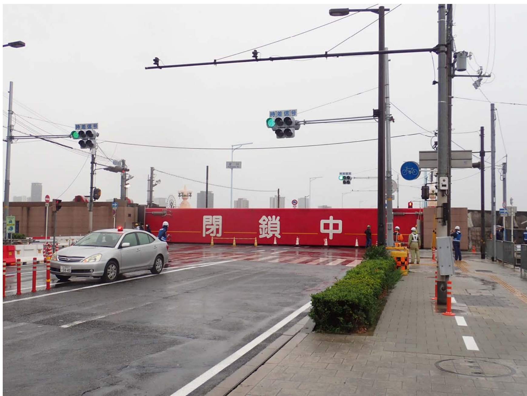
陸閘の閉鎖状況
