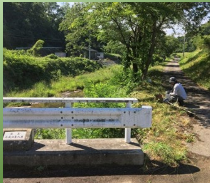
施工中の横吹橋の様子
