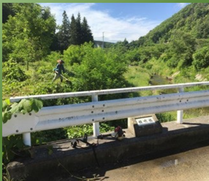
施工中の横吹橋の様子
