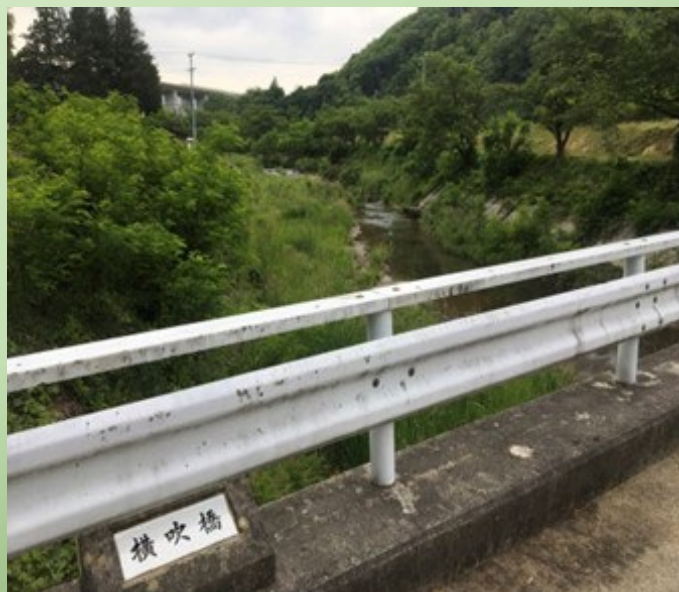
施工前の横吹橋の様子
