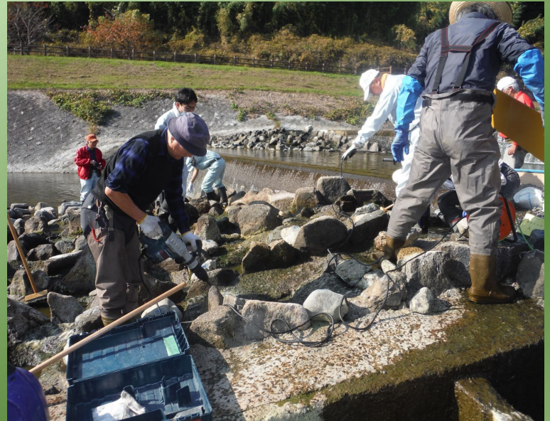
石の魚道補修工事の様子
