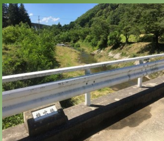
施工後の横吹橋の様子
