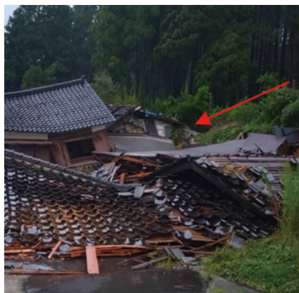
9/21 がけ崩れ 石川県珠洲市若山町広葉
