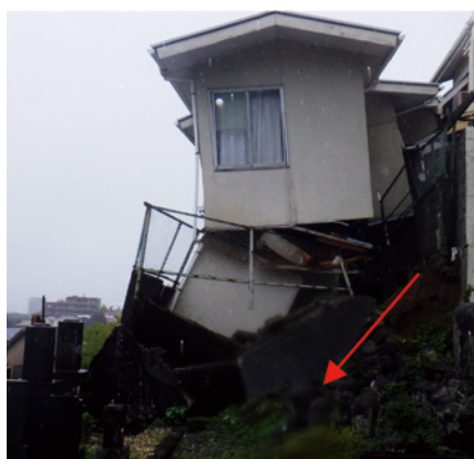
8/30 がけ崩れ 神奈川県小田原市城山
