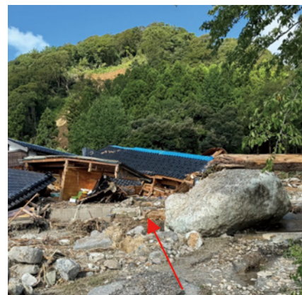
9/21 土石流等 石川県輪島市町野町南時国
