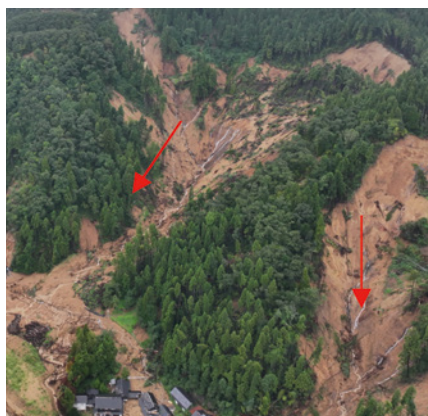
9/21 地すべり 石川県輪島市町野町川西
