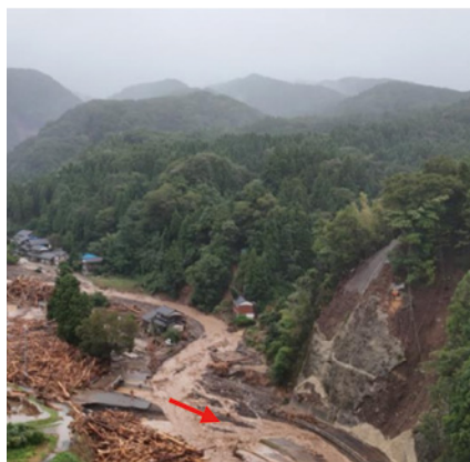
9/21 土石流等 石川県輪島市久手川町
