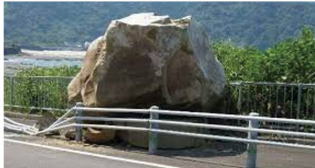
地震による道路への落石発生
