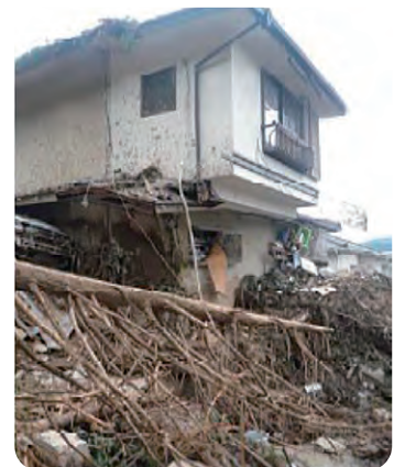
広島市の土砂災害による住宅被害状況 (国土技術政策総合研究所HP)
