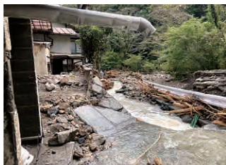
9/24 土流等の状況 静岡県静岡市葵区油山 (国土交通省HP)
