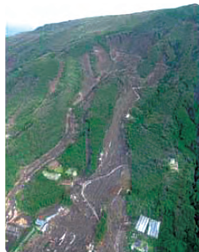
大島町本町大金沢の土砂災害 (国土交通省関東地方整備局 HP)
