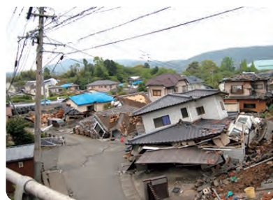
一階部分が倒壊した家屋(九州地方整備局HP)
