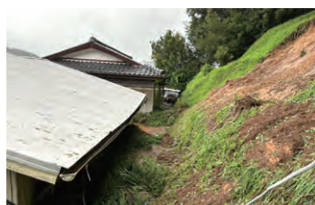
9/19 げけ崩れの状況 宮崎県日之影町七折 (国土交通省HP)
