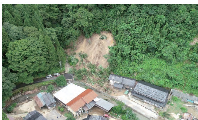
8/5 がけ崩れの状況 石川県小松市中ノ峠町 (国土交通省HP)
