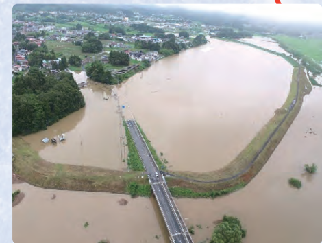
7月の出水 鳴瀬川水系吉田川の浸水状況 宮城県大郷町（国土交通省東北地方整備局HP）
