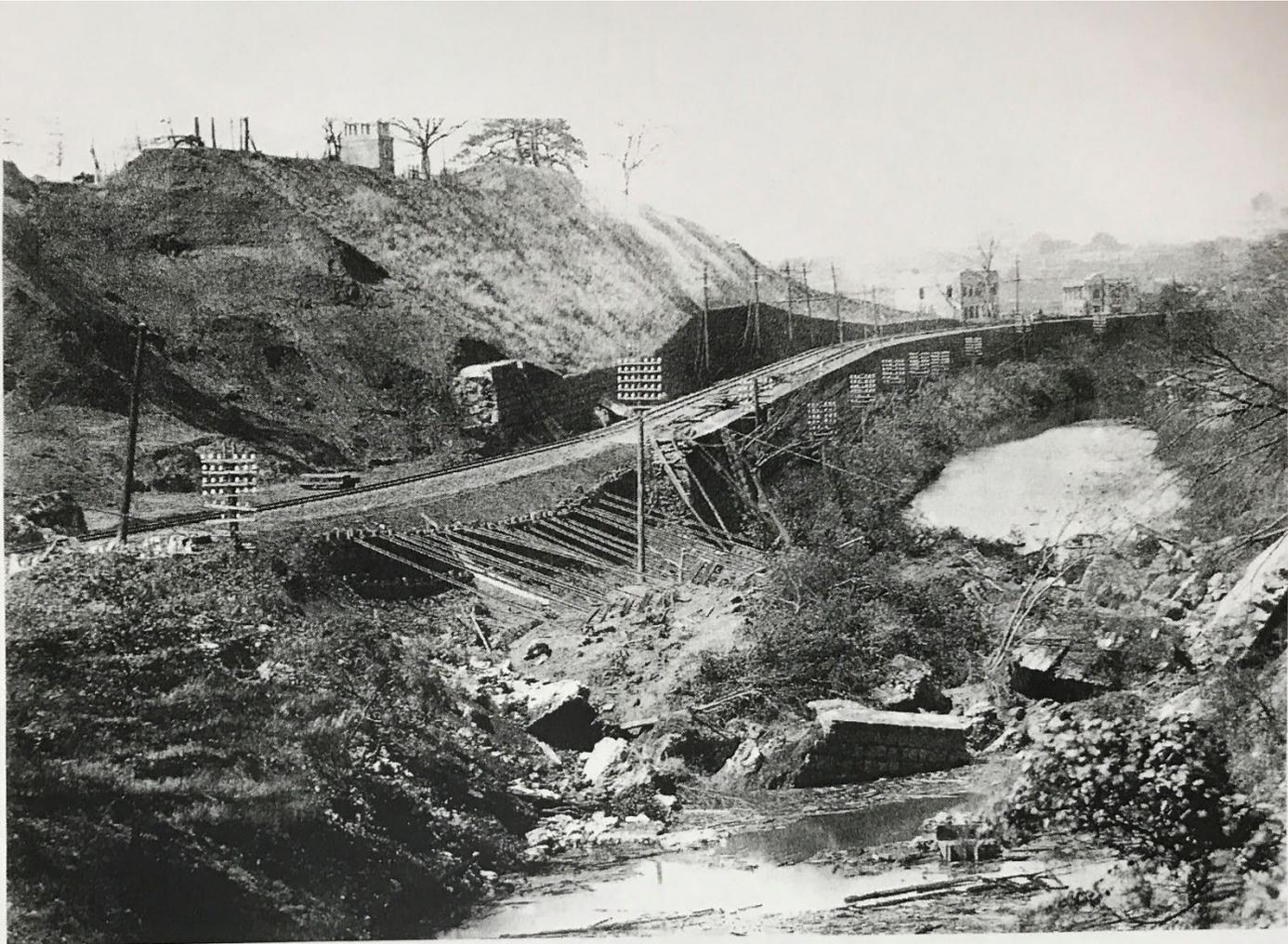
御茶ノ水駅附近／土砂及線路土留石垣崩壊外濠埋没ノ惨状
