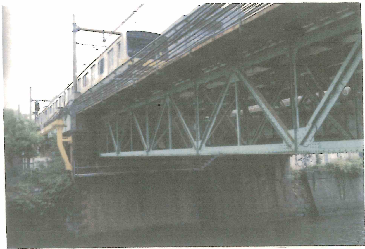
図-13 日本橋川を渡る中央線橋梁
