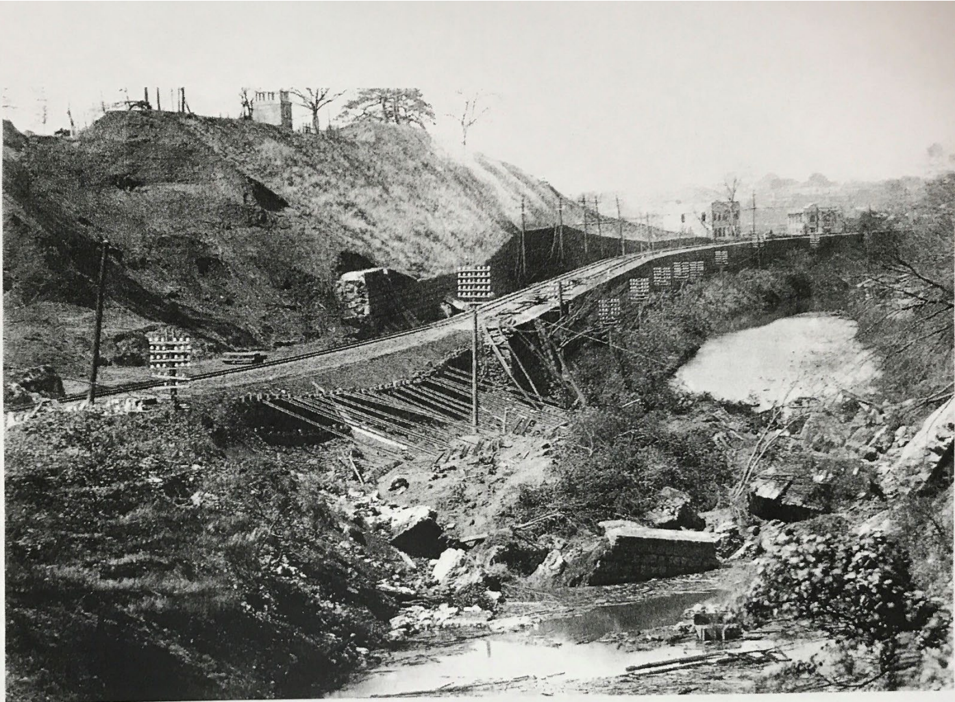
御茶ノ水駅附近／土砂及線路土留石垣崩壊外濠埋没ノ惨状 (線路ハ土砂崩壊ト同時ニ外濠内ニ決壊)
