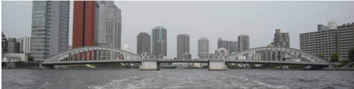
横長写真は、HP「東京橋物語」掲載写真 右上写真は、銭高組HP掲載写真
