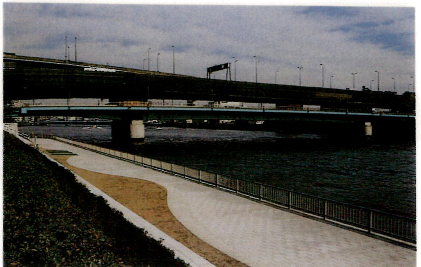
隅田川大橋 Sumidagawa-ohashi
