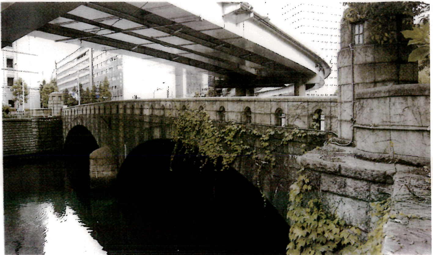
常盤橋 (大正15年初めて架橋)
