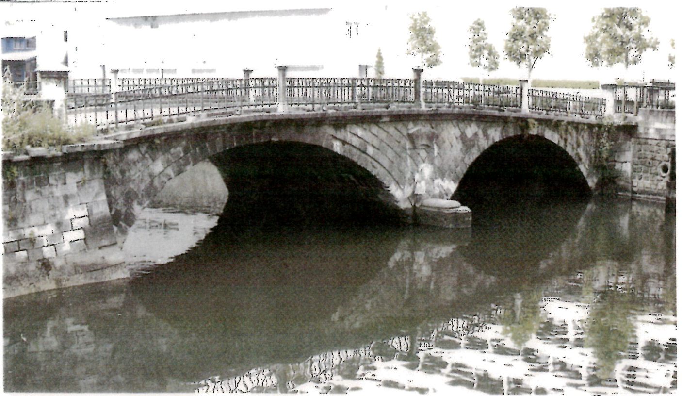
常盤橋 (明治10年常盤橋門の入口の木橋を架け替)
