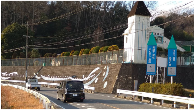
校庭に建てられた「清流の塔」、道行く人も透視度調査を見守る
