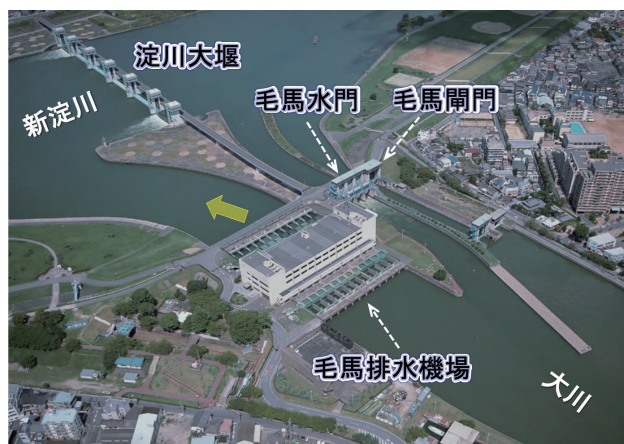
写真1 淀川大堰とその周辺
