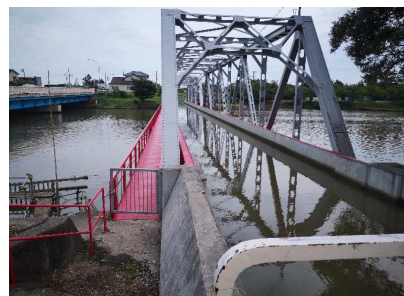
現在の西川・新川交差部
