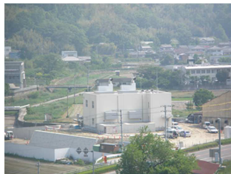
写真4 現在の川島排水機場 (平成21年改築)
