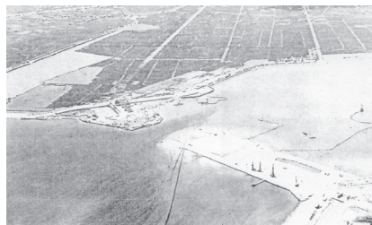
昭和 37 年出水期に向け進む河口締切工事 (愛知県海部建設事務所提供)
