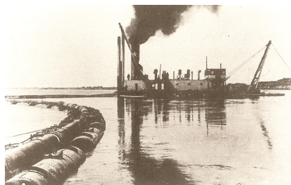
写真3 水中掘削を行うポンプ船
