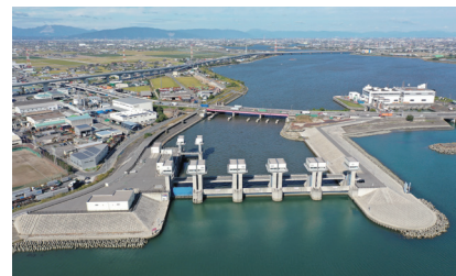
現在の河口水門：日光川水閘門 (愛知県海部建設事務所提供)
