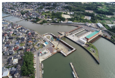
施工中の新川河口自然排水樋門
