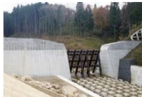
砂防関係施設整備
