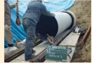
管路の更新・耐震化
