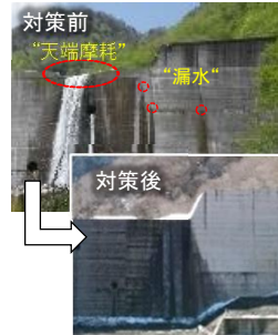
砂防堰堤の改築
