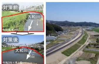
河道掘削・堤防整備
