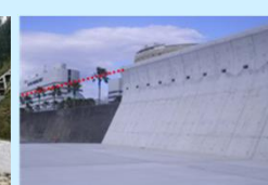
海岸保全施設整備
