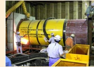
水道用水の相互融通のための 連絡管設置(神奈川県HPより)
