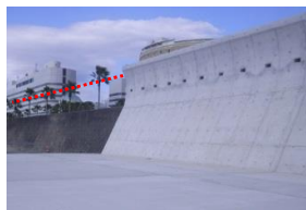
海岸保全施設整備
