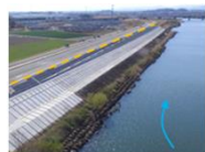
[パイロット施工実施状況]
