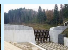
砂防関係施設整備
