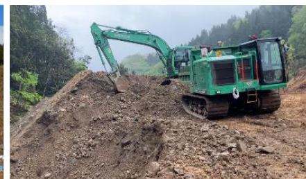
③河道閉塞箇所における遠隔施工実施状況
