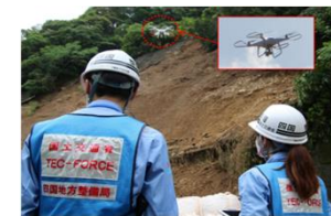
ドローンを用いた被災状況調査
