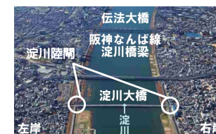
例：淀川水系淀川 淀川陸閘整備事例
