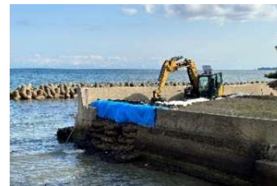
袋詰玉石、大型十のう敷設完了
