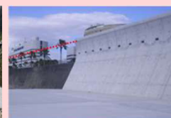
海岸保全施設整備
