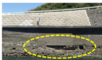
護岸の損傷
