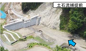
おとし 乙石川上流1号砂防堰堤
