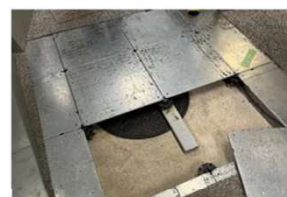
能登空港ビルにおける活用事例 (建物地下に設置された雨水貯留槽)
