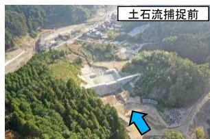
くえんたに 崩谷川砂防堰堤
