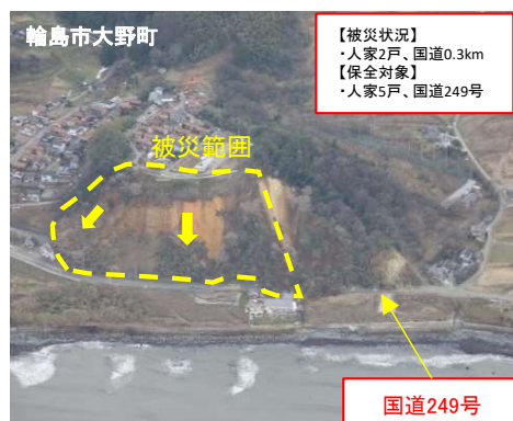
国道249号を寸断した地すべり災害
