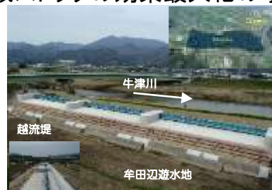
六角川水系牛津川 牟田辺遊水地の越流堰改築
