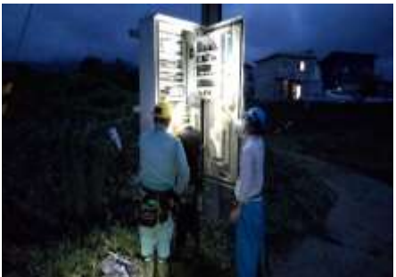
揚水機能の復旧確認
