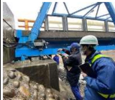
緊急調査状況(富山県新庄川橋)
