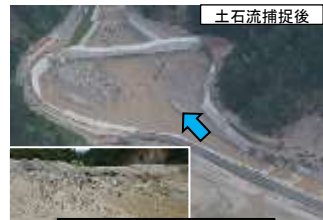
土石流捕捉後
