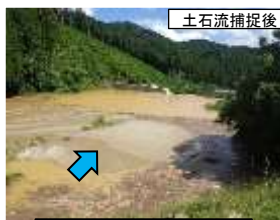
土石流捕捉後
