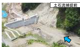
おとし 乙石川上流1号砂防堰堤
