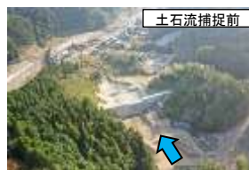
くえんたに 崩谷川砂防堰堤
