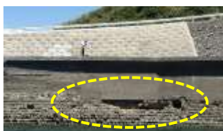
護岸の損傷
