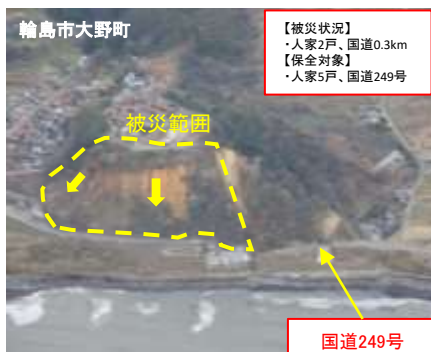
国道249号を寸断した地すべり災害
