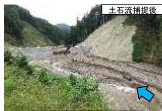
土石流捕捉後
