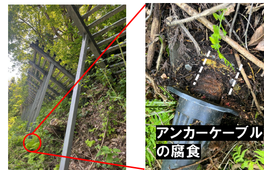
■雪崩予防柵のアンカーの損傷
