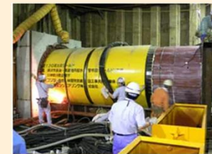
水道用水の相互融通のための連絡管設置(神奈川県HPより)
