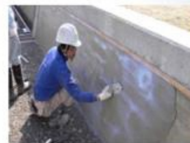
老朽化した水路壁のコーティング
