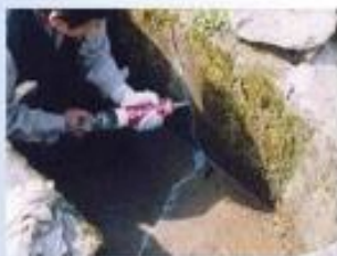
水路のひび割れ補修
