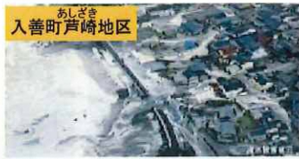
平成20年2月低気圧による被害状況
