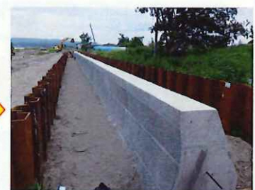
本復旧状況（護岸復旧）
