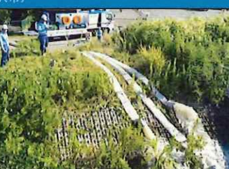
排水ポンプ車による排水支援 [内水排除] (8月8日 石川県金沢市)
