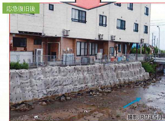
護岸の応急復旧状況
