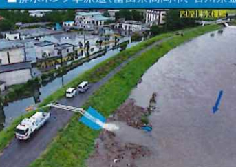
排水ポンプ車による排水支援 [排除能力増強(四屋排水機場)] (8月7日 富山県高岡市)
