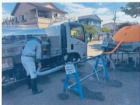
給水スポットの設置、給水車による給水
