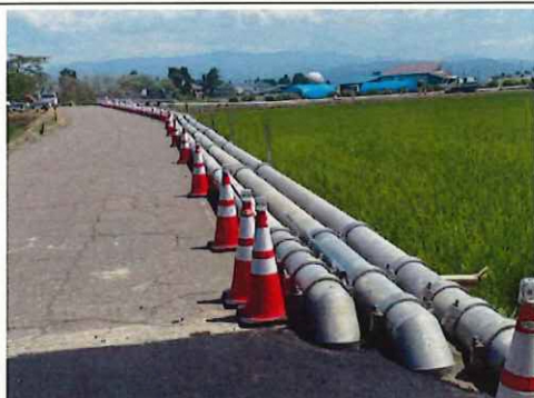
上越妙高駅の消雪用井戸から城山浄水場までの配管工事(8/5完了)
