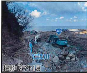
仮設護岸工の施工状況
