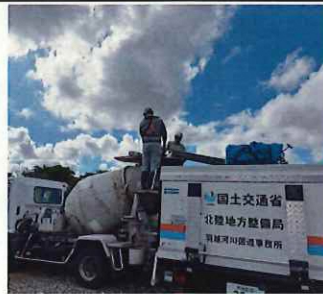
積込状況 (コンクリートミキサー車)
