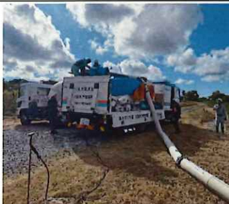
河川水のくみ上げ状況 (排水ポンプ車)
