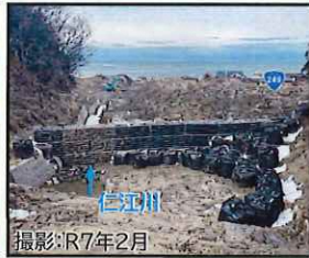
土砂流出防止工の整備状況
