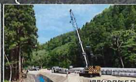
仮設堰堤の施工状況
