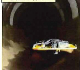
ドローンによる目視調査
