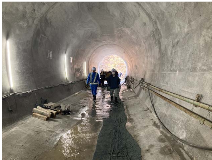
転流工（堤外仮排水トンネル）
