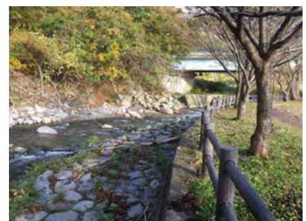
河川公園より上流の状況
