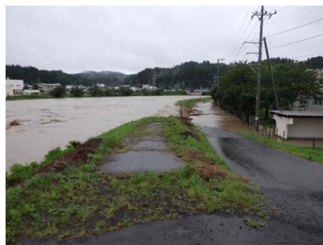
中村川 鰯ヶ沢病院付近の越水状況 (R4.8.9 撮影)
