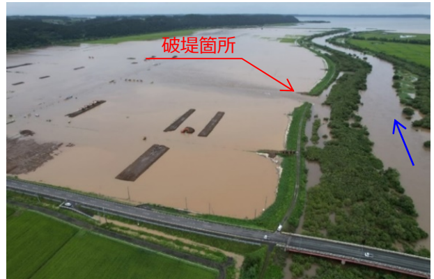
＜写真＞高瀬川堤防決壊箇所（七戸町川口）R3.8.10
