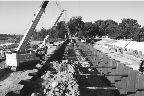
〈写真—5〉二重締切工施工状況
