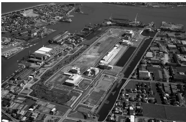
宮川浄化センター全景
