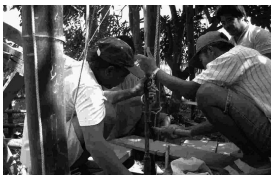
写真7. キロキロ小 ひごをくさびで接続中
