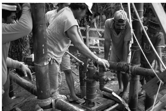
写真8. キロキロ小 ポンプを据え付け水が出たところ
