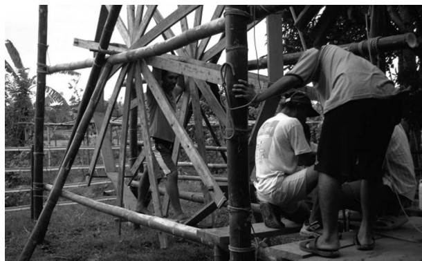
写真6. キロキロ小 槽の中に人が入りひごを下げている
