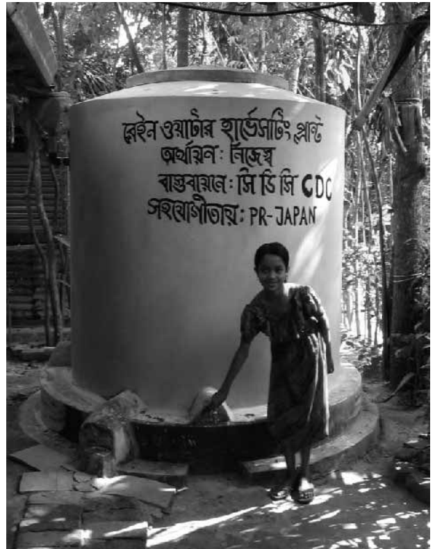
写真2 バングラデシュに設置されたリングタンク
