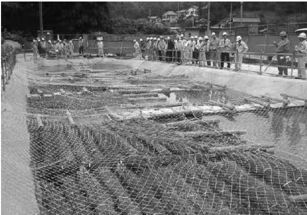
竹そだ濾過工法による仮設沈殿池 現地研修
