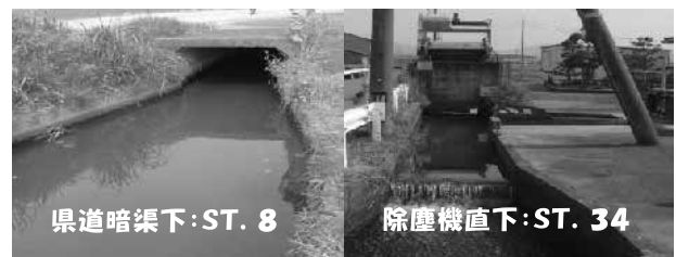
写真6 暗渠下・除塵機下部
