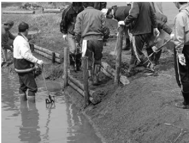
写真10 地元ボランティアによる造成作業
